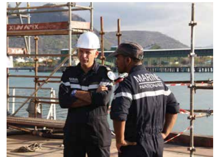
Le commandant Deschamps supervise les travaux.
