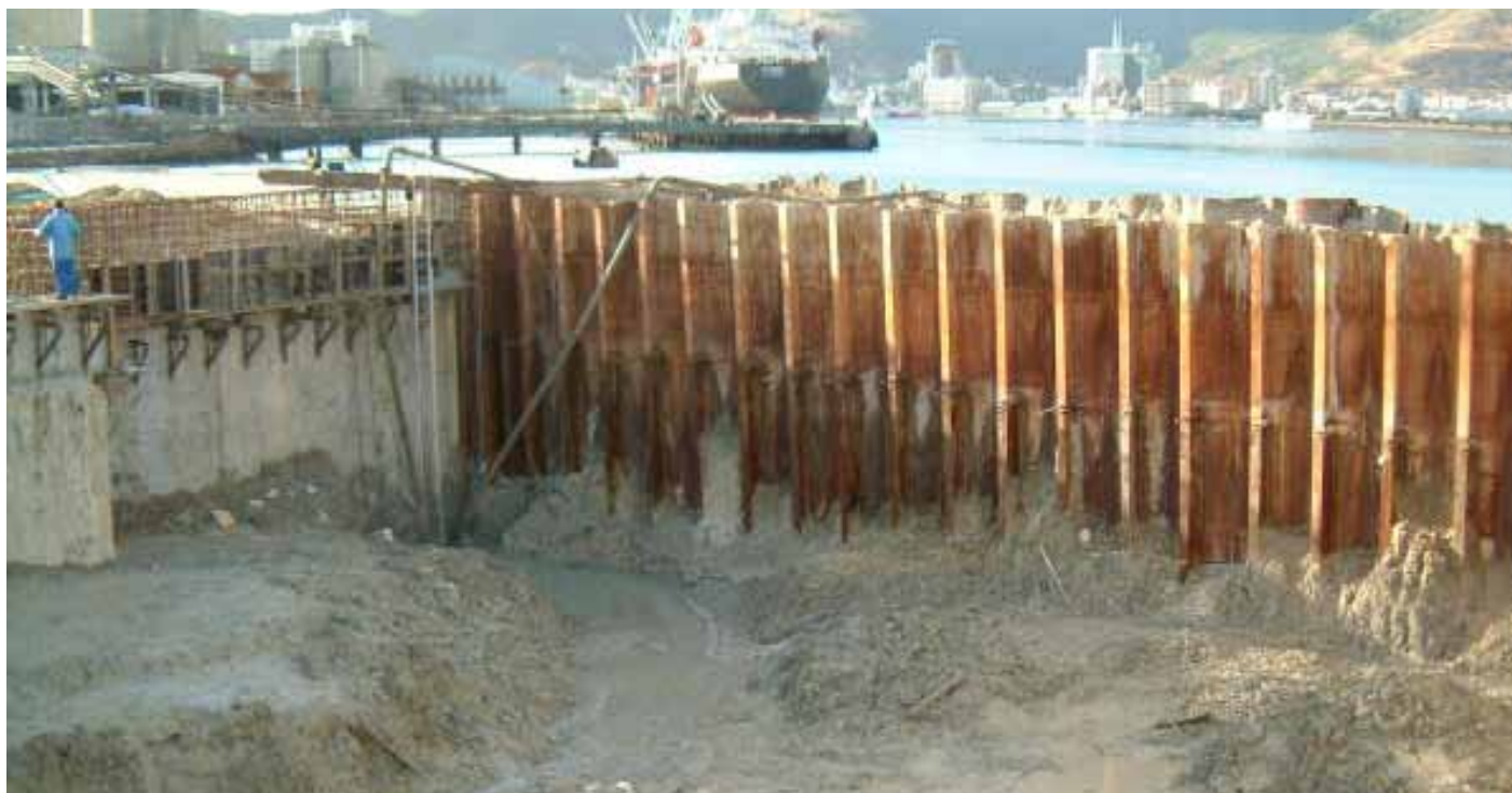
L'étanchéité de la cale, avant la mise en place de la porte, s'est faite par la pose de pales-panches.
