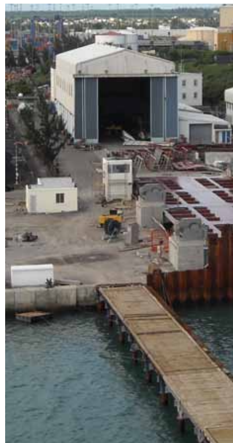
Mise en place de la plateforme de l'élévateur.
