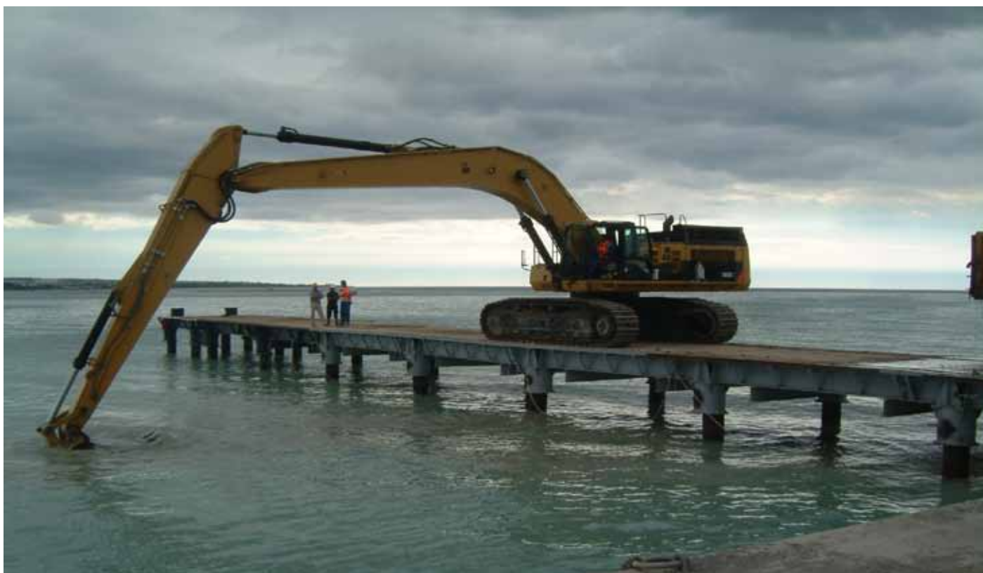
Opérations de dragage par pelleteuse pour le nouveau quai.
