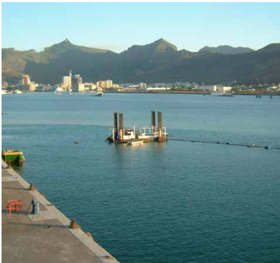
Le dragage en vue de l'extension des quais.
