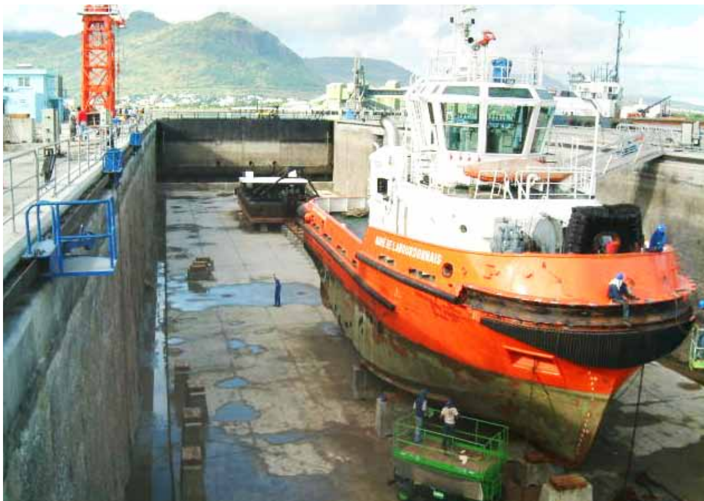
Opérationnelle, la cale sèche est vite devenue un atout majeur du Chantier.
